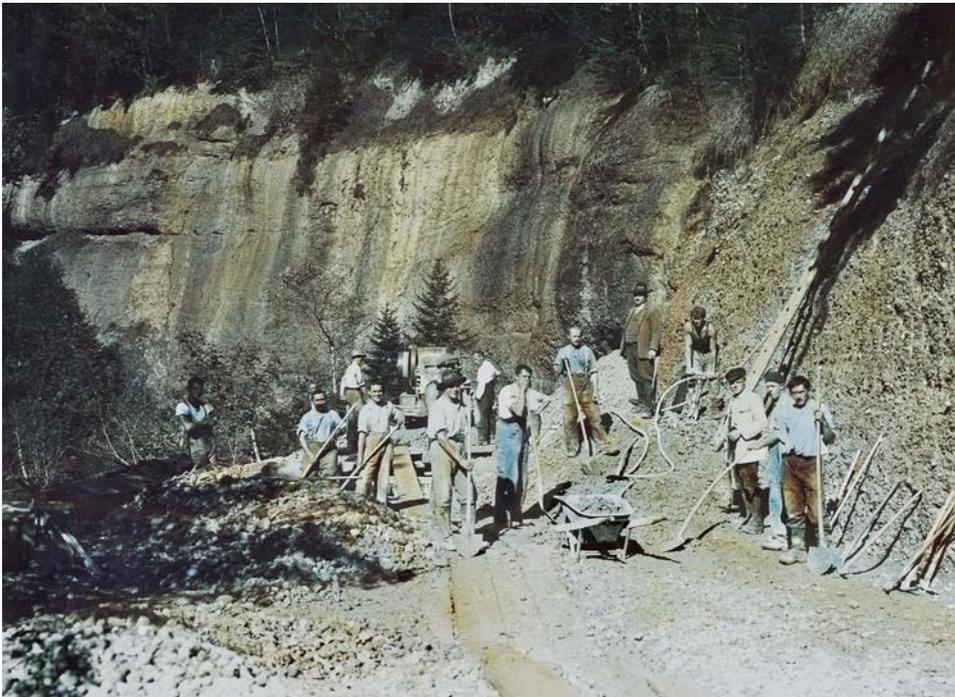
Abb. 12: Unterhaltsarbeiten an der neu erstellten Strasse entlang der oberen Töss zwischen Buri und Tössscheidli (kurz vor 1900). Die ab 1885 erstellte Strasse wurde an dieser Stelle in den Fels gesprengt; in den folgenden Jahren wurde sie von Hochwassern wiederholt beschädigt oder gar weggeschwemmt (Quelle: Abteilung Wald Kanton Kt. Zürich).
