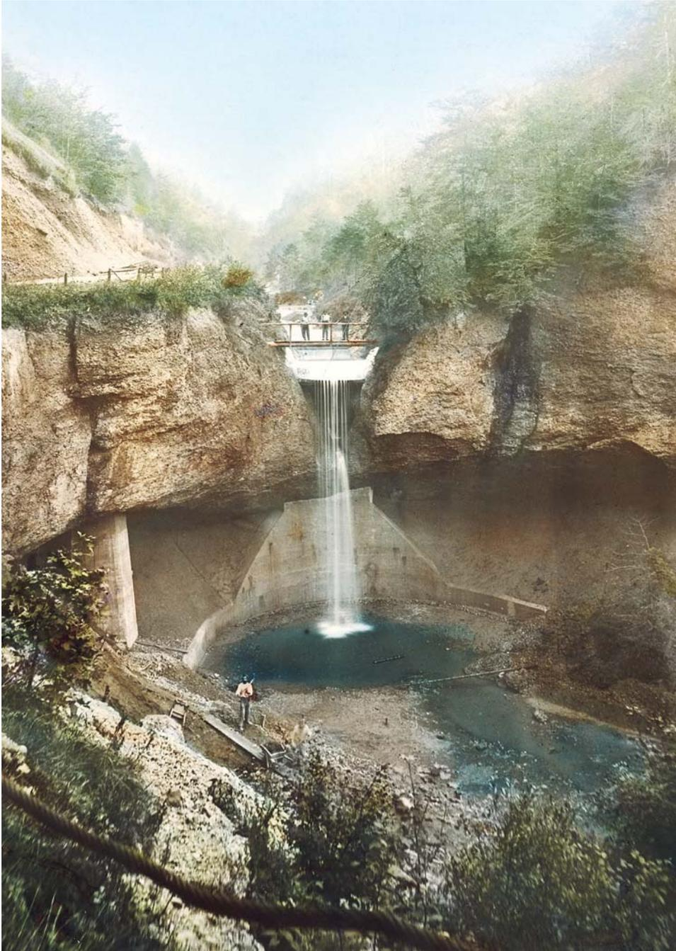
Abb. 13: Obere Töss beim Wasserfall Lauf. Aus Beton wurden Stützbauten zur Stabilisierung der unterspülten Nagelfluh gebaut, was das Abrutschen der Strasse verhindern sollte. Von diesen Betonbauten ist heute nichts mehr zu sehen (Quelle: Abteilung Wald Kanton Zürich).
